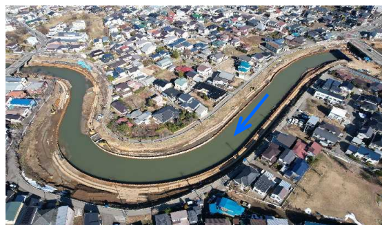
太平川(秋田市) 《河道掘削・護岸工事》
