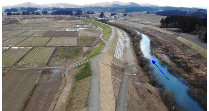
復旧工事完了
