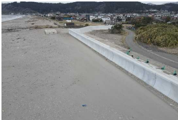
《老朽化した護岸の機能強化を実施》 (男鹿海岸(脇本・船越地区) 男鹿市)
