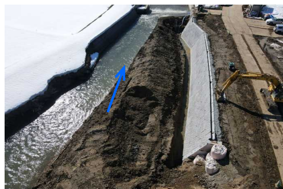
内川川(五城目町) 《河道掘削・護岸工事》
