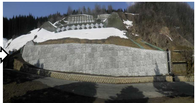
復旧工事完了
